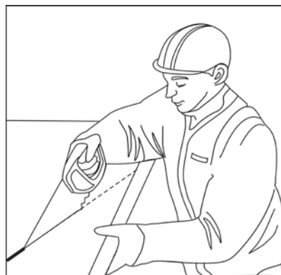
Рисунок 6.1 – Раскрой теплоизоляционных плит с использованием ножовки ручной
